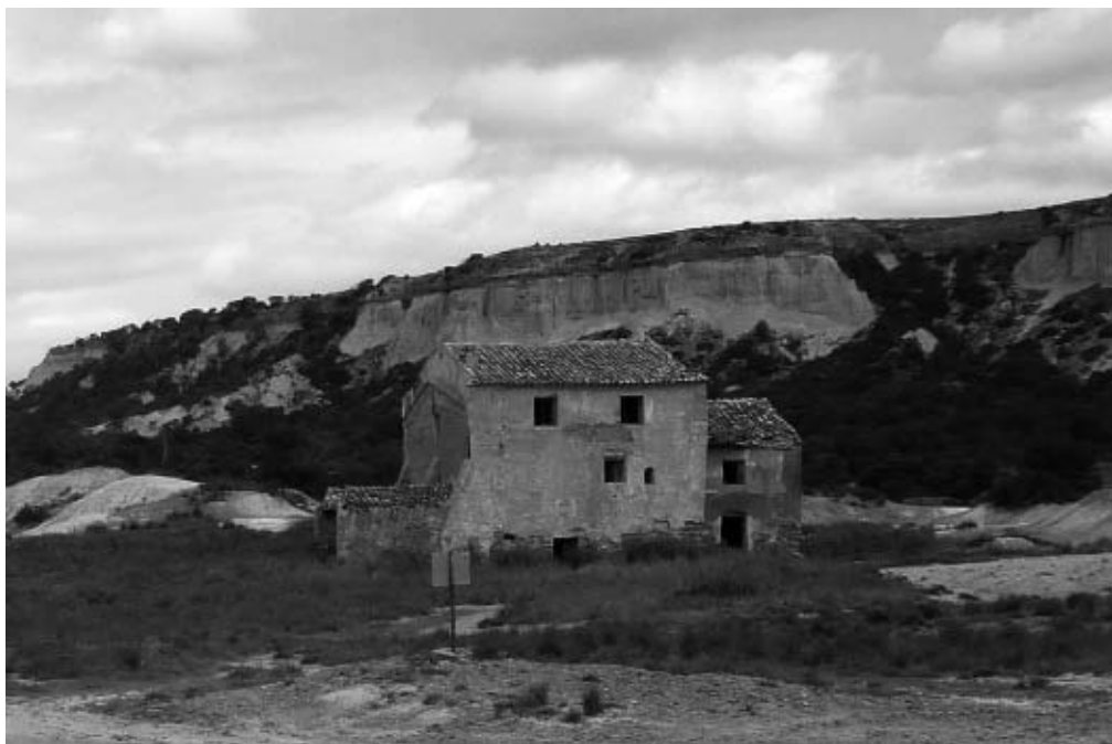
Estado actual de la casa y ermita del Vedado de Eguaras.
