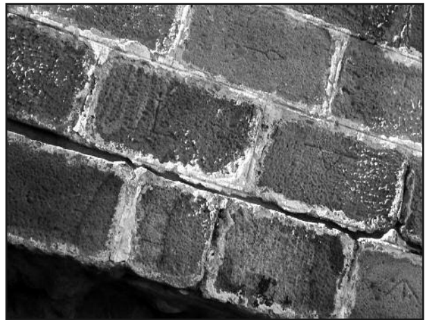
Figura 5.- Como se puede apreciar en esta fotografía, en los sillares que forraban las nuevas torres dejaron los canteros castellanos abundantes marcas justificativas para cobrar su trabajo. Fotografía del autor.
