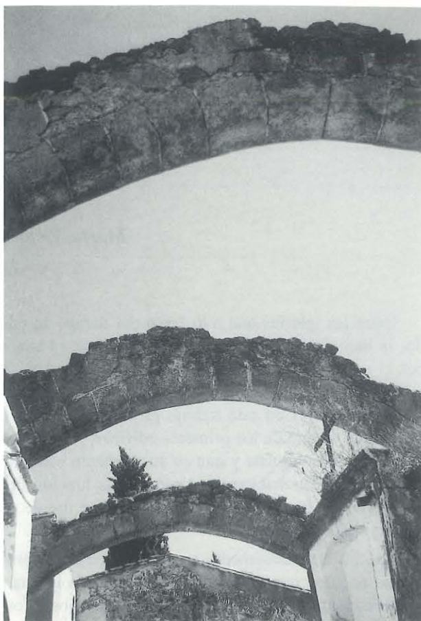
FIG. 1. Iglesia de la Vera Cruz. Arcos de la nave.
