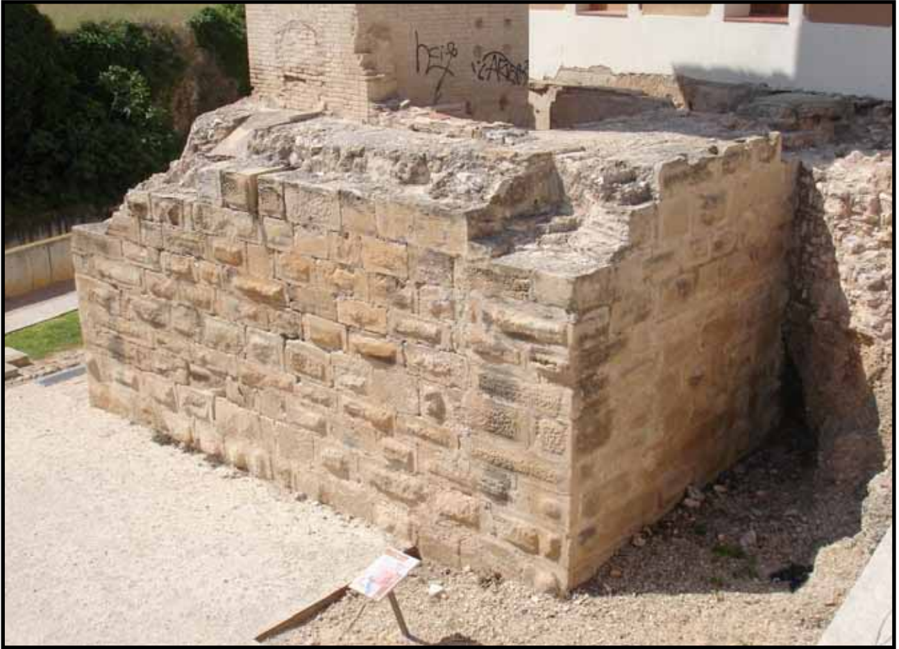
Torre de Sant Joan a l'extrem nord-occidental del hisn d'Amposta
