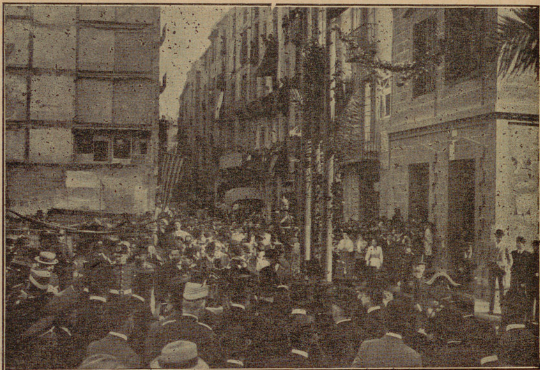
Aspecto que presentaba la calle de la Reina Regente al visitar el rey las obras de reforma interior de Barcelona.
