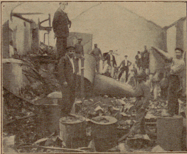
Badalona.—Incendio de la fábrica de barnices de los señores Colomer, Ofarrill y C. a , ocurrido durante la madrugada del 23. Dicho establecimiento fabril quedó completamente destruido por las llamas.
