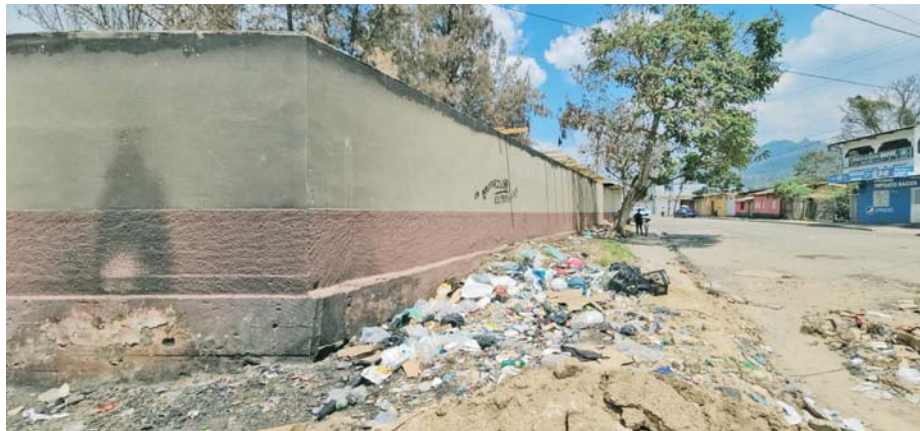
Este hotel recientemente se quemó, incendio originado por la quema de basura y para colmo los desechos aún se siguen tirando en el mismo sitio.
