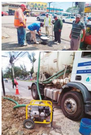
En el bulevar del Norte, en Comayagüela, se realizaron trabajos de sustitución de conductos taponados y se usaron varillas y una bomba succionadora.
