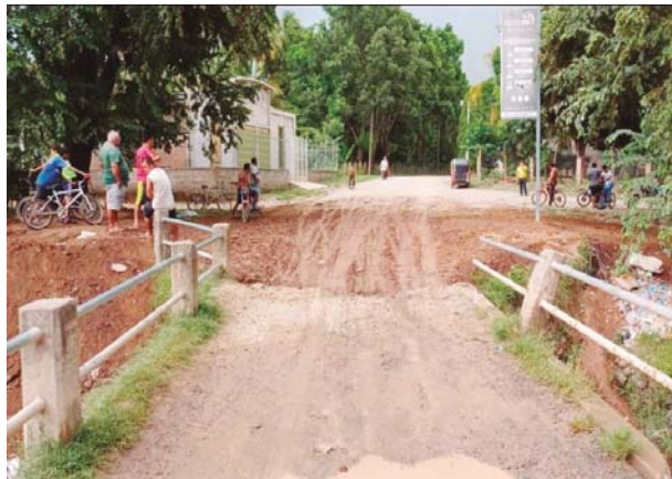
Habilitado quedó el paso para personas y vehículo sobre el puente.
