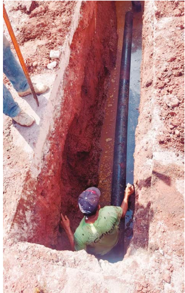
En la colonia San Carlos fueron sustituidos por tubería de PVC dos lances de tubo de concreto que estaban obstruidos por grasa depositada en los tragantes.
