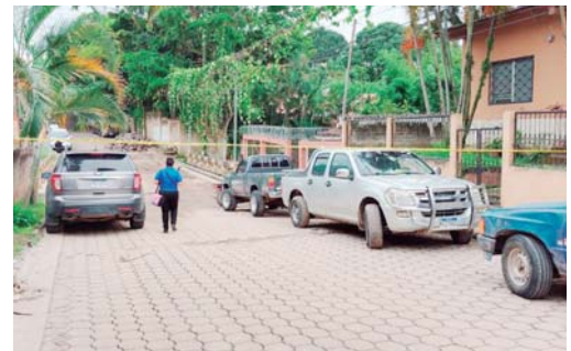
Los puentes del Barrio Abajo, Buenos Aires, Zaragoza fueron cerrados al tránsito vial por el colapso de las bases.
