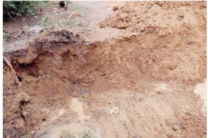
Los daños en la comunidad de El Rincón y alrededores han sido cuantiosos.
