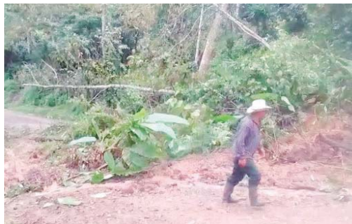
En San Ignacio y El Sauce se avanzó con los trabajos de rehabilitación ante un deslizamiento que obstaculizaba el paso.
