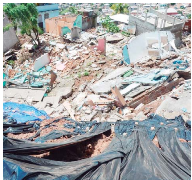
El movimiento de suelo por las lluvias continúa, terminando de derribar lo poco que queda de las viviendas.
