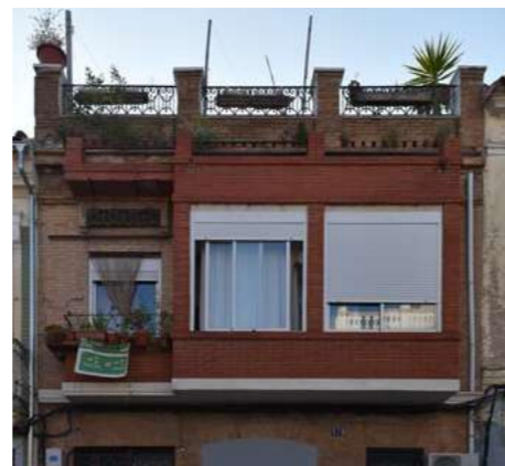
Mirador añadido no adecuado, incoherente con el entorno.
