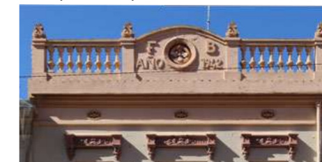
Vivienda C/ d'Escalante nº287
