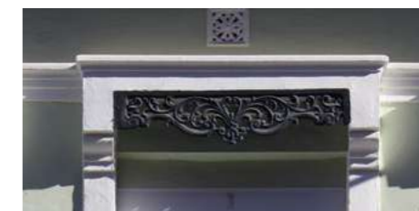
C/ L'Arquitecte Alfaro nº76
