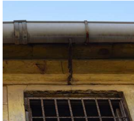
Oxidación de poleas.
