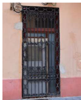
Modificación de la carpintería.
