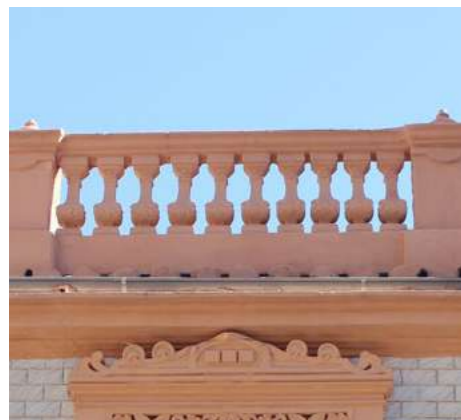
Revestimientos no adecuados.
