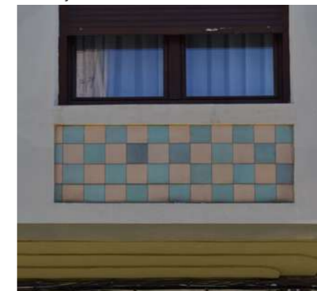
C/ Josep Benlliure nº30. Detalle colocación
