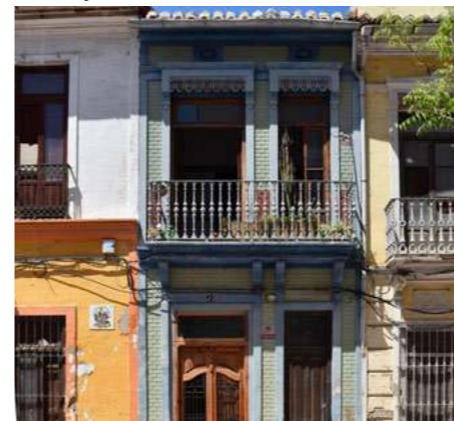
C/ Sant Pere nº75. Fachada completa
