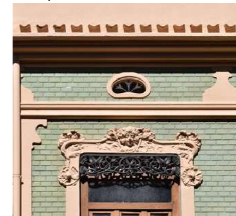
C/ de la Reina nº117. Detalle colocación
