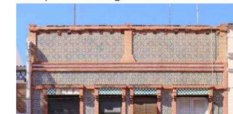
Vivienda C/ d'Escalante nº295
