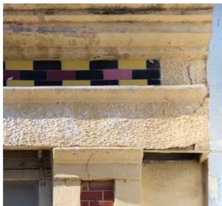
Aplicación de pintura plástica.
