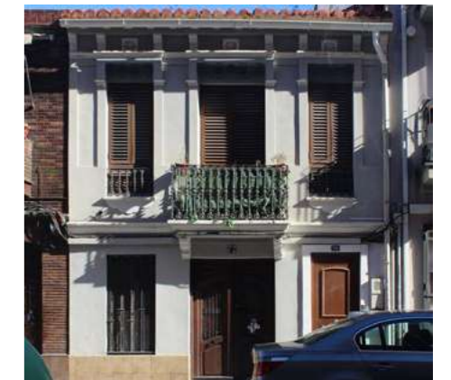
C/ L'Arquitecte Alfaro nº72
