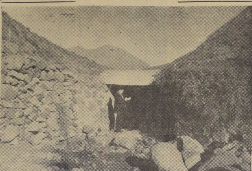
LA SERENA.— Al fondo de una quebrada, cerca del cerro de Juan Soldado, se ve en el grabado la actual pasada de los vehículos por la Carretera Panamericana, sobre una alcantarilla de 4 metros y formando una peligrosa y estrechísima curva. Pero el progreso evitará este paso obligado hasta ahora con el nuevo puente que será entregado al uso público en agosto próximo.
