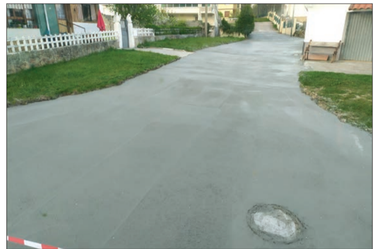
Por otro lado, se ha hormigonado de la pista de los chalets en Quintana de los Prados.
