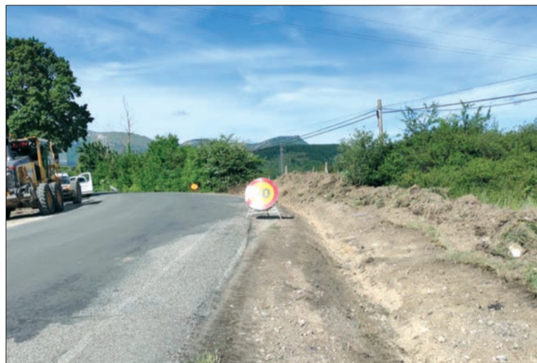
El repavimentado de cunetas y bermas de la BU-V-5433 en Villasana de Mena dio comienzo el 16 de mayo.
