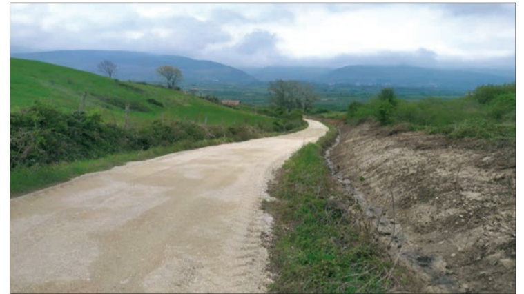
Se ha acondicionado la pista que sube a la antigua explanada del petróleo en la zona de la Peña, un trabajo realizado por la empresa Ignacio Sainz Maza.
