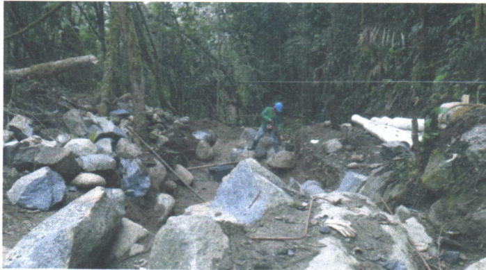
FOTO 30. PERFORACION DE ROCAS EN EL DESARENADOR
