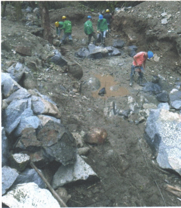
FOTO 28. ZONA DE DESARENADOR , RETIRO DE SOBRANTES Y DE MATERIAL
