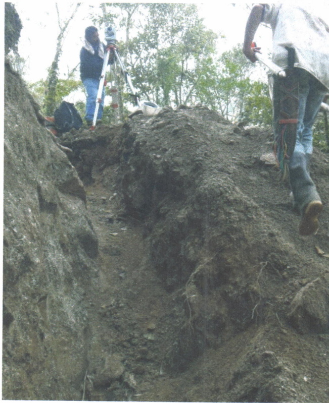
FOTO 19. REVISION TOPOGRAFICA A LA LINEA DE CONDUCCION
