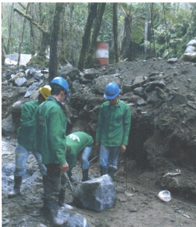
FOTO 26. RETIRO DE ROCAS EN DESARENADOR
