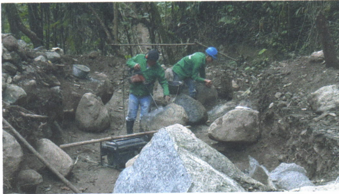
FOTO 29. PERFORACIÓN DE ROCAS EN ZONA DE DESARENADOR
