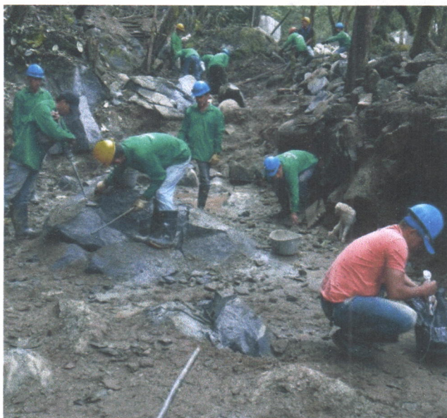
FOTO 27. RETIRO DE ROCAS EN ZONA DE DESARENADOR
