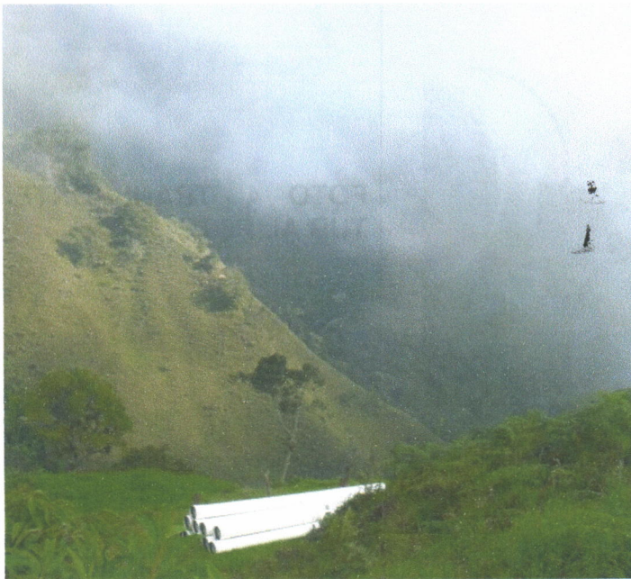
FOTO 2. TRANSPORTE DE TUBERIA AL PASO ELEVADO N°3.
