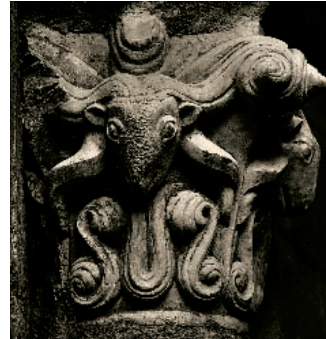
Arriba: La reubicación de algunos capiteles en la segunda etapa constructiva, les supuso daños irreversibles [V3-D].
