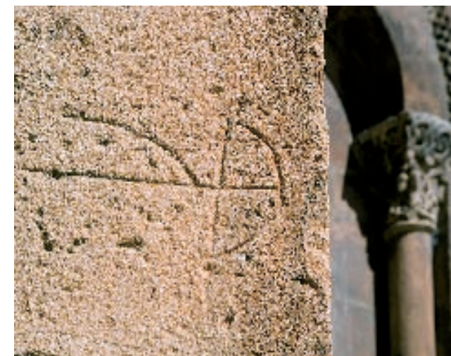
Abajo: Marca de cantería con forma de ballesta situada en el hastial del brazo sur del crucero.
