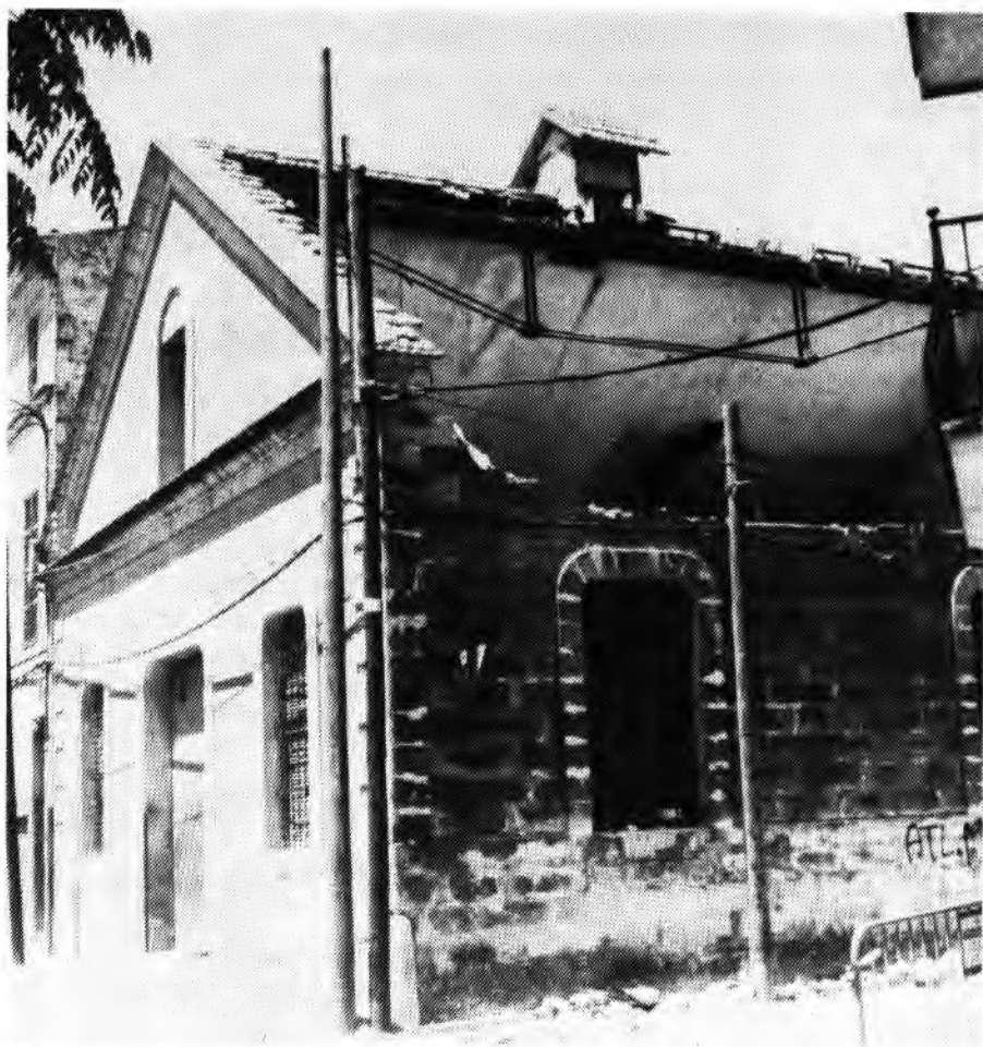
La fàbrica de pintes en procés de demolició.
