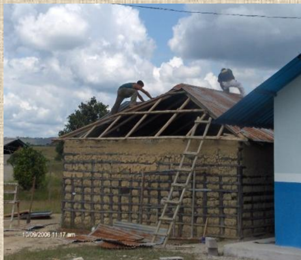
Demolición de Ambulatorio Tradicional Comunidad Chiricayen.
