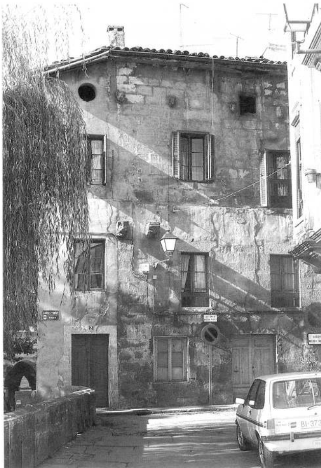
Torre de Lariz.
