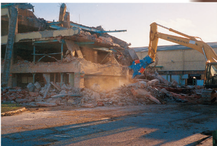
DEMOLICIONES EDIFICIOS DE HORMIGÓN
