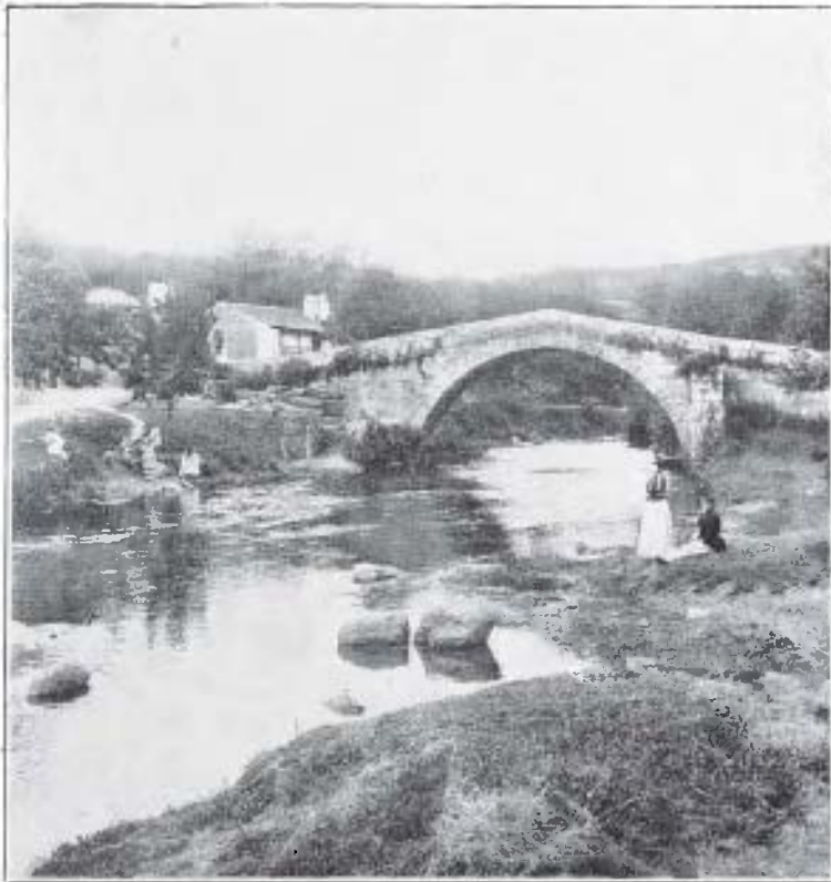
PUENTE DE CELA DE CAMBRE. EN LA PROVINCIA DE LA CORUSA
