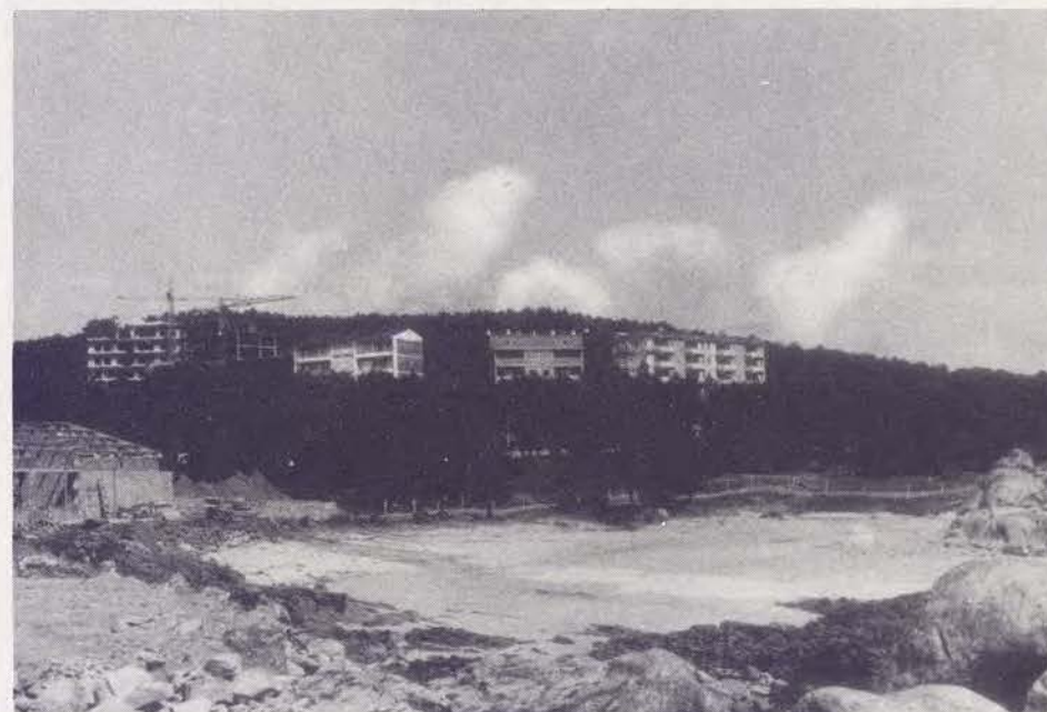
Muelle deportivo y Club Náutico, en construcción.
