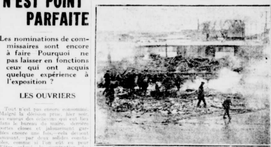
Quelques débris calcinés et fumants, voilà tout ce qui reste du magasin Vézina et Filion, incendié hier à Limoilou.
