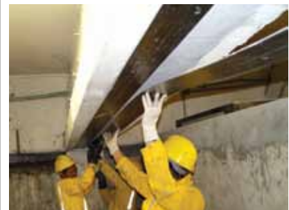
6. Reforzamiento a flexión de las vigas de un puente con platinas de fibra de carbono Sika CarboDur®-S1012 .
