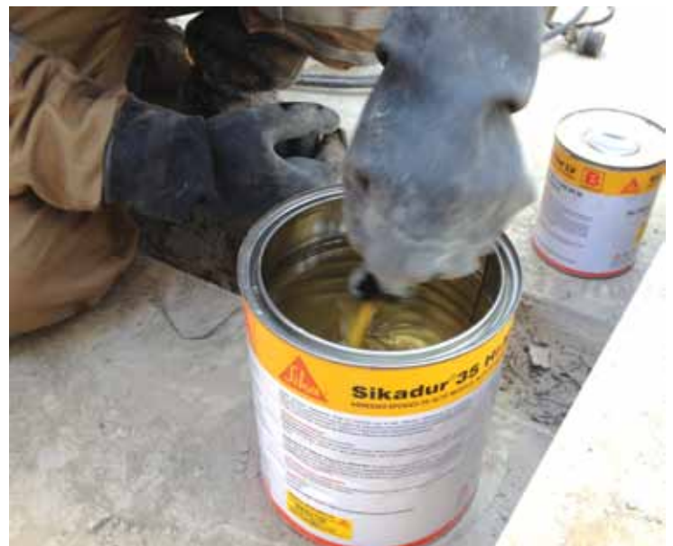
Figura 9b. Sikadur®-35 Hi Mod LV, resina epóxica de baja viscosidad para la inyección de fisuras en elementos estructurales.
