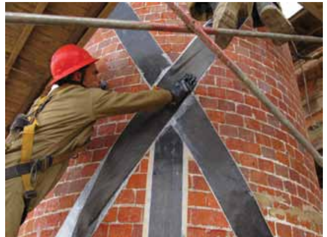
Figura 11 c. Reforzamiento de una chimenea de mampostería con SikaWrap ® -600C.
