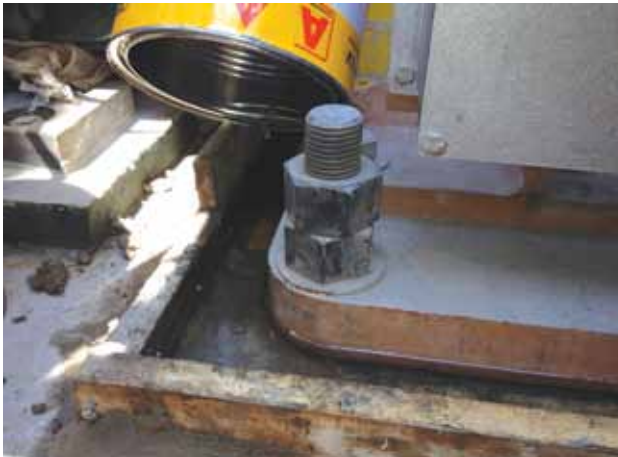
Figura 9a. Inyección por gravedad de una fisura en una losa de fundación (soporte de un equipo).
