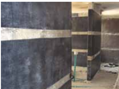
4. Reforzamiento a cortante de los muros de un edificio con el tejido de fibra de carbono SikaWrap®-600C .
