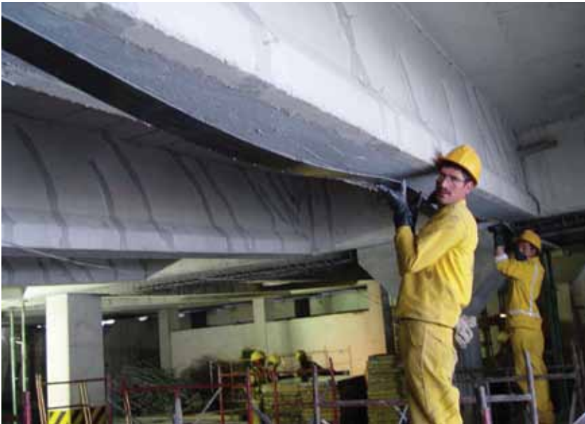
Figura 11b. Colocación de las platinas de fibra de carbono Sika CarboDur ® en la parte inferior de las vigas del puente.
