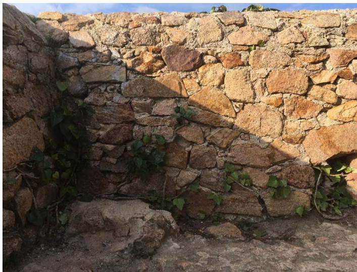
Imatge 40. Reconstrucció de remat del mur amb formació de barana.
