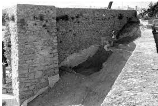
Imatge 31. Construcció de les escales el 2018.
