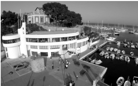
Imatge 29. Vista actual del Club Nàutic.
