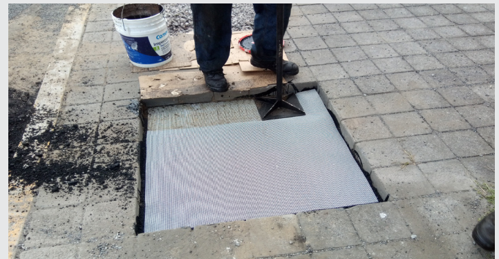
Figura 4. Incorporación de la geomalla en la estructura de la carpeta. Fuente: Elaboración propia.
