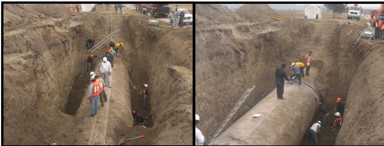
**DEMOLICIÓN, DESINSTALACIÓN Y EXTRACCION DEL TUBO A SUSTITUIR FUERA DE LA ZANJA.**
