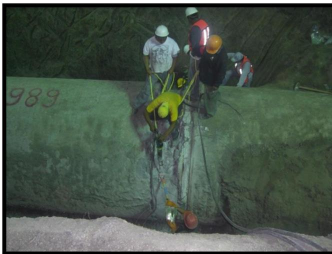
Desinstalación y/o desconexión y extracción de tubería de concreto preesforzado de 99" de diámetro para cambio de tubos de 5.00 o 7.32 m de longitud.
