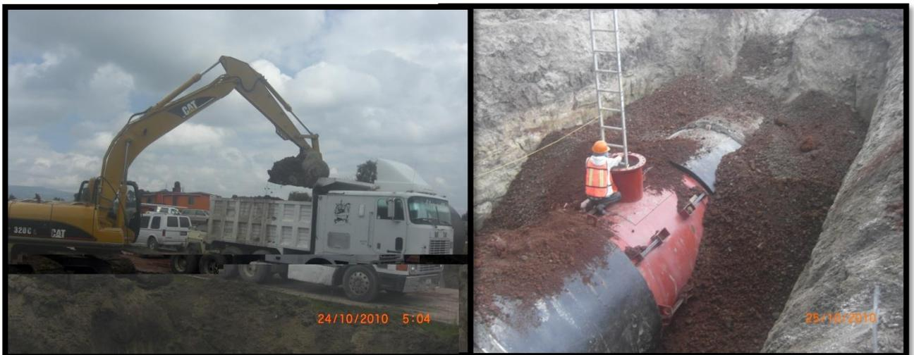
Relleno a volteo con material producto de la excavación,
