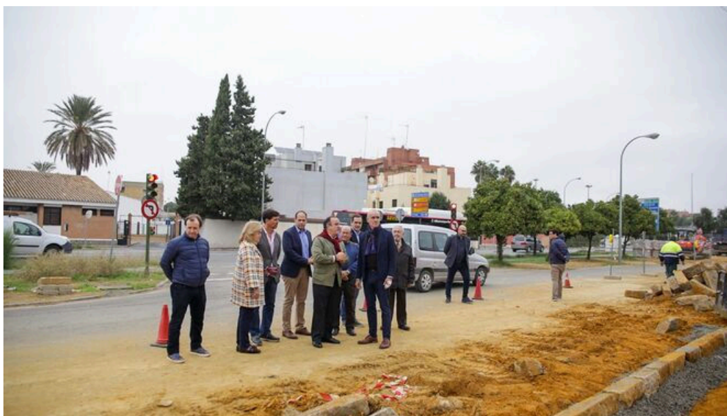
El Ayuntamiento ejecuta en el PICA una nueva inversión de 273.000 euros para itinerarios peatonales / M. G.
