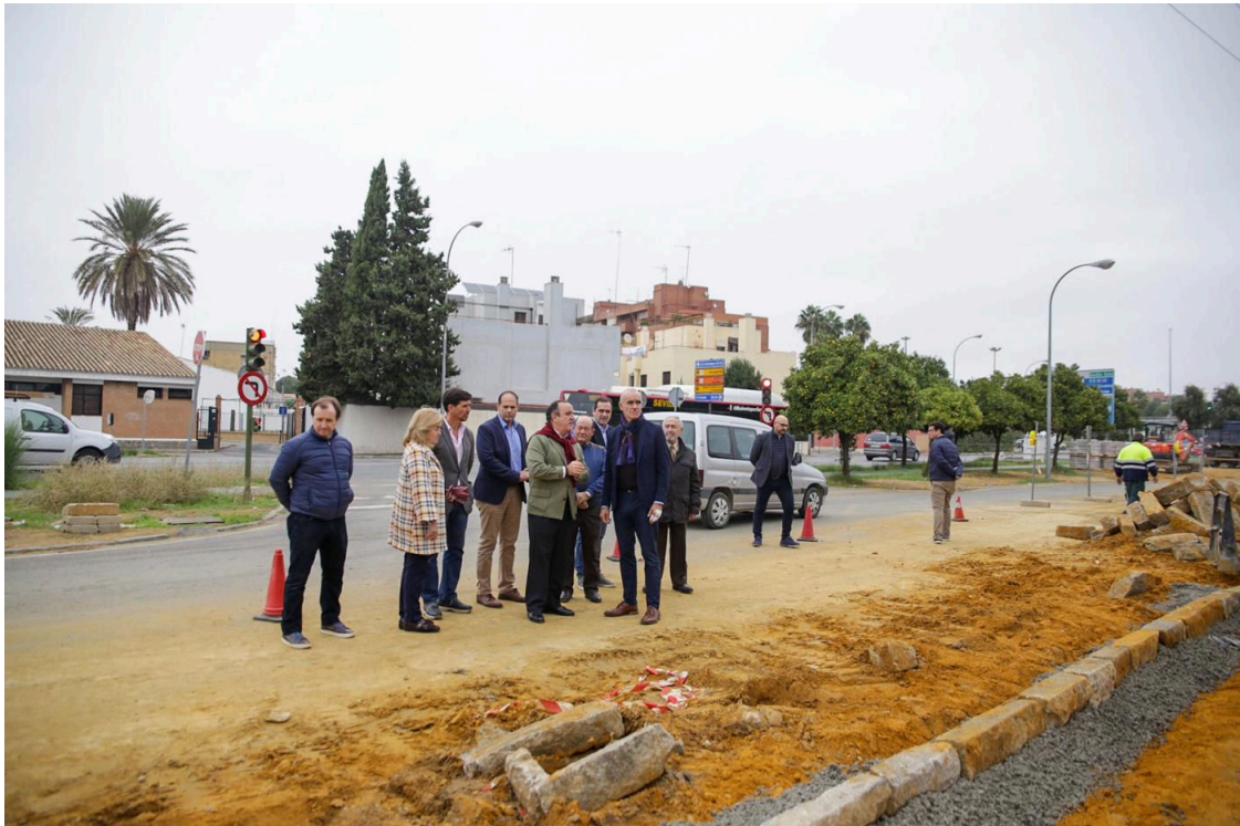
Visita a las obras del PICA. Ayto
