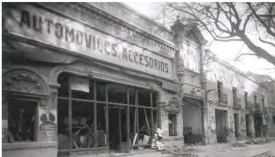
Fotografía 18. Fotografía de Antonio Alfaro. Según el propietario de la instantánea ésta fue tomada "después de un bombardeo" hacia 1937. Copia de la fotografía inserta en el Expediente Construcción de un garaje y sus dependencias anexas num. 102, en el Paseo de Alfonso XII, num. 4 .Proyecto de garaje - 02.04.1925 por Julio Carrilero - AMAB Planero 3-15.
