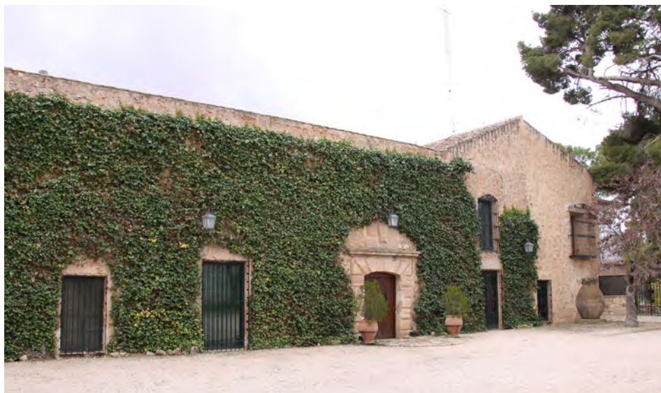
Imagen 3: Fachada y puerta principal de la Casona. Foto: Luis García Solana.
