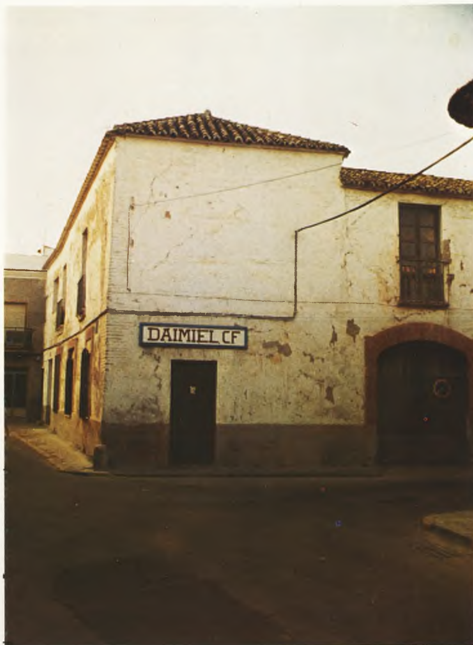
Antiguo edificio de la "Tahona de Ayala" que será derruido próximamente para construir sobre el solar resultante de 1.160 m 2 ., un nuevo edificio de tres plantas, destinado a Centro de Salud con 1.789 m 3 . construidos y Centro Social Polivalente (Hogar del Pensionista) con 883 m 2 .
