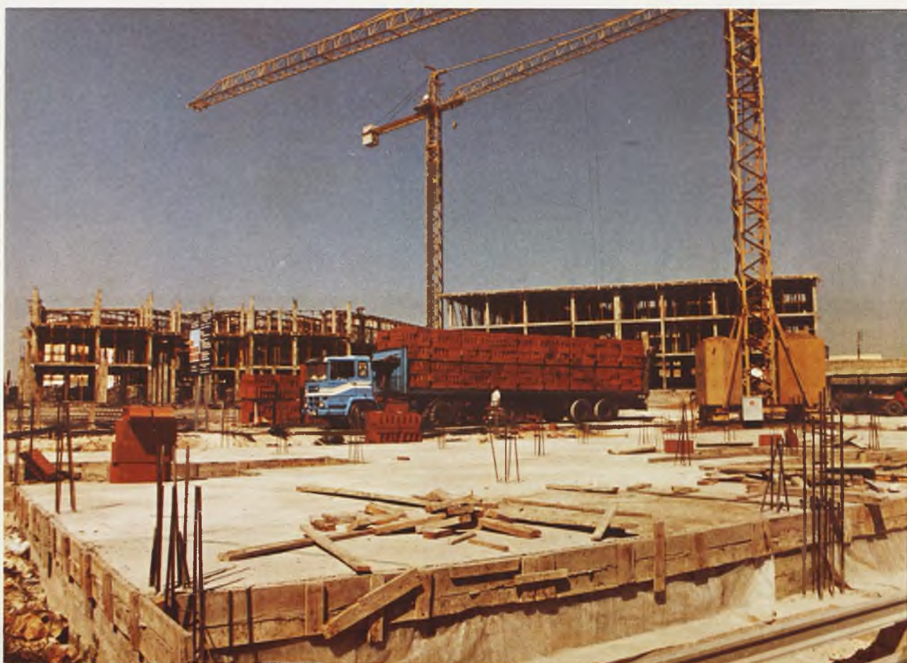
Obras de construcción de 132 viviendas de Promoción Pública, situadas en el antiguo "Lavadero", calle Arcipreste Julio Mata, cuya terminación está prevista para el próximo año.
