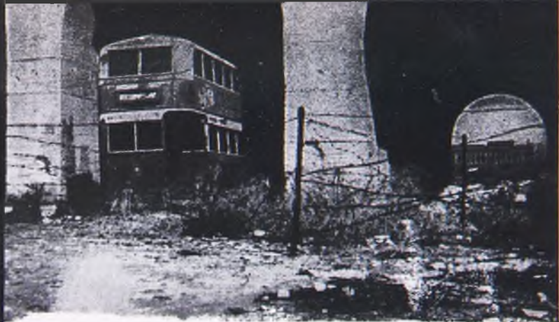
Posiciones del gran viaducto en la Ciudad Universitaria. Debajo de uno de los arcos se ve uno de los autobuses de Madrid abandonado por los rres.
