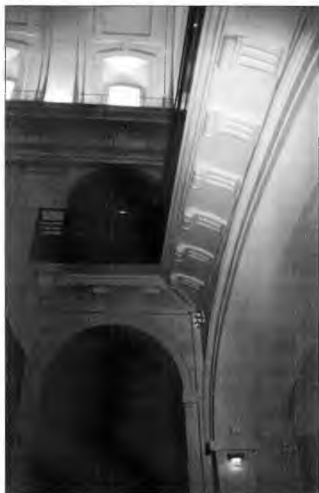
Lámina 8: Embocadura del sotocoro y detalle inferior del coro, tras la rehabilitación.
