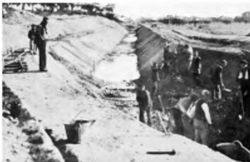
Otra de las imágenes que nos muestra el trabajo de los presos en el canal. Se observa el trabajo a pico y pala.
