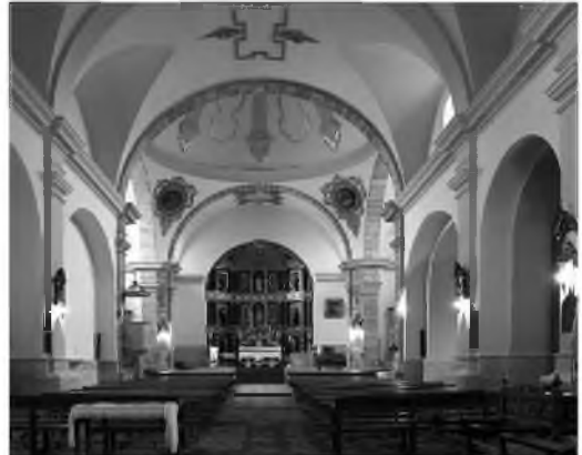
Vista del interior. Iglesia parroquial de San Blas. Valdeverdeja.
