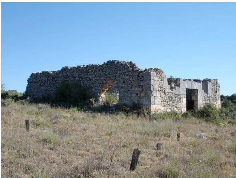
Estado actual de las ruinas de la ermita de San Matías, en lo alto del monte del mismo nombre.
