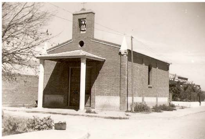
Ermita nueva de la Virgen de la Soledad, sede de la cofradía. El 12 de octubre de 1974 se dio por concluida su construcción. Conserva en cada una de sus esquinas cuatro de los capiteles de la ermita antigua, que primero estuvo dedicada a la Virgen del Rosario. (Foto Jesús Andrés Pérez).
