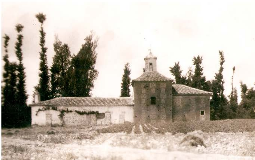
Ermita de la Virgen de la Granja, antes de expirar el siglo XIX. La nave bien puede ser de fines del siglo XIV o principios del XV. La capilla mayor y la sacristía-camarín fueron edificadas entre 1696 y 1701. Un patronato velaba por el mantenimiento del culto y su hacienda. (Gentileza de Gregorio Santiago Redondo).
