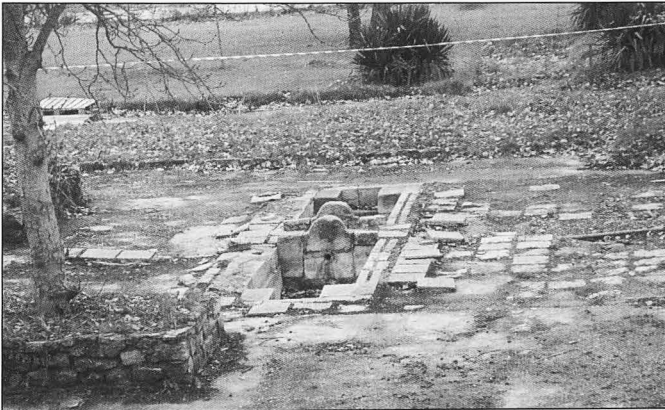
Foto 5.- Balneario de Trillo en reconstrucción.
