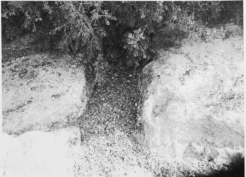
Canal excavado en la roca perteneciente a la acequia del riego del Cerro de los Molinos. S. XVII.
