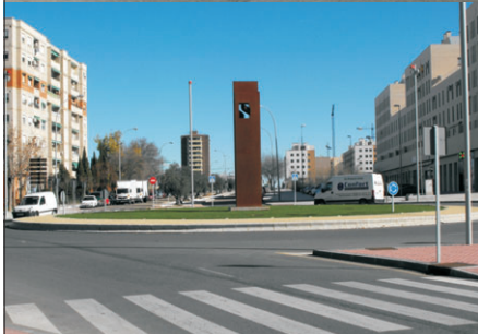
La rotonda de Cascajoso, antes y después.
