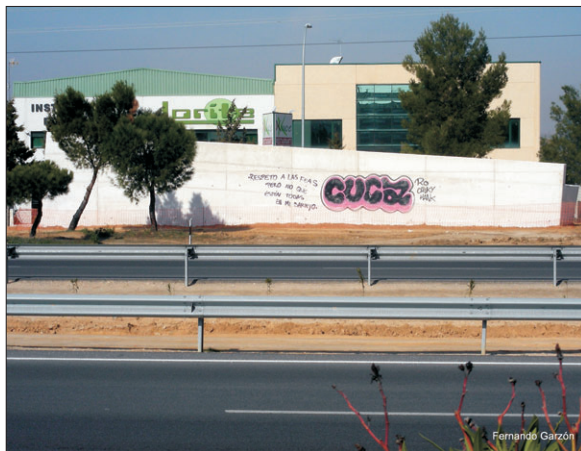
Punto de apoyo y rampa para el montaje de la pasarela.
