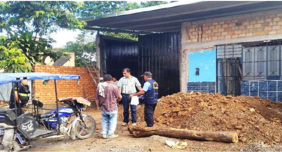
CONTROL EN CONSTRUCCIONES
