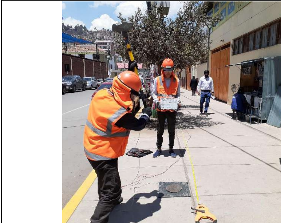
FOTO 04: Personal geofísico ejecutando SHOT 02 del ensayo MASW-02 ZONA: Sencico – Sede Cusco.
