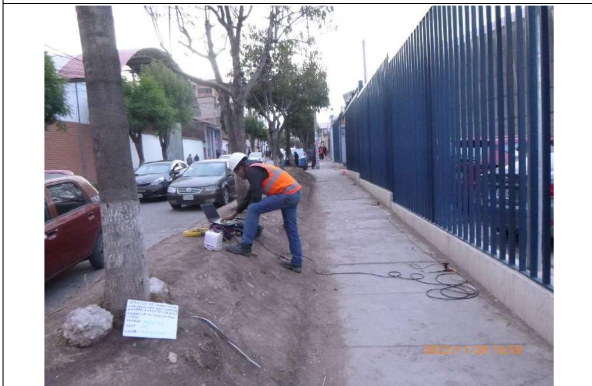
FOTO 02: Personal coordinando el tendido del cable de refracción para el ensayo MAM-01. ZONA: Sencico – Sede Cusco.
