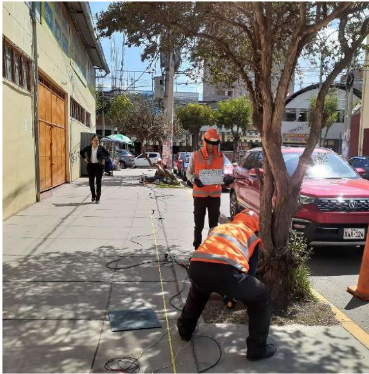
FOTO 01: Personal geofísico ejecutando el impacto SHOT 02 para la línea LS-01. ZONA: Sencico sede Cusco.
