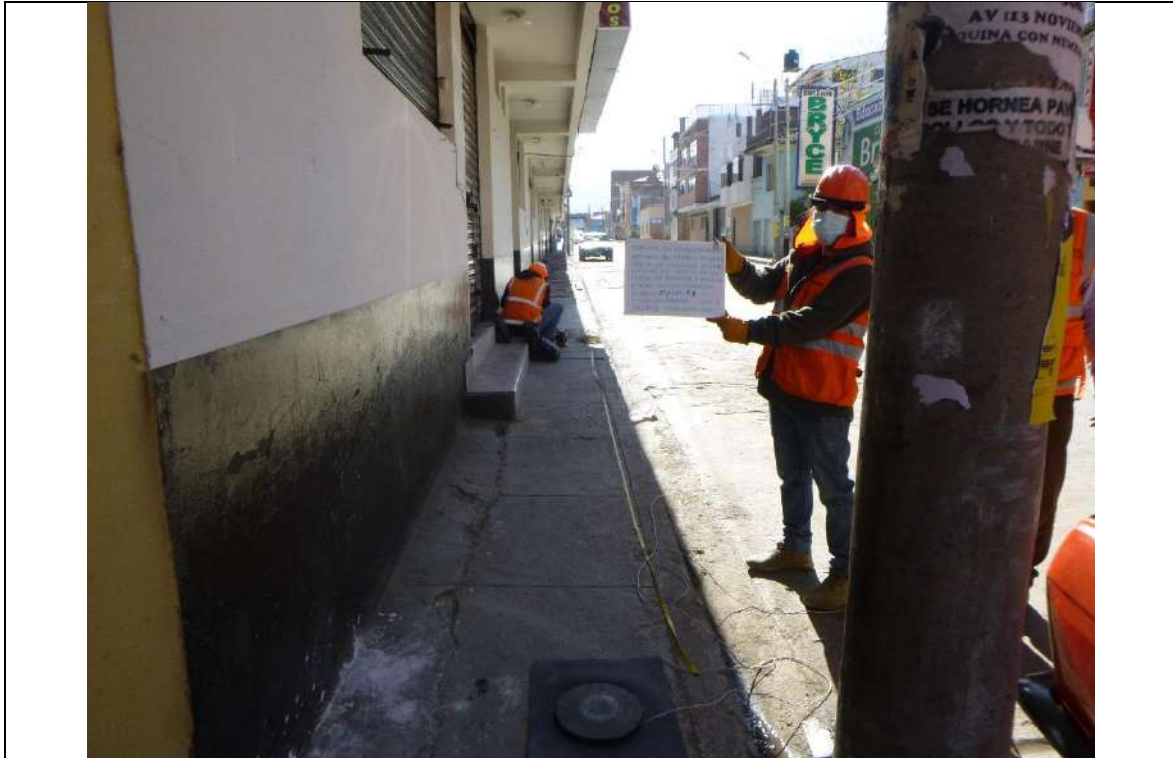
FOTO 01: Área sobre la que se ejecutó el ensayo MASW-01.
