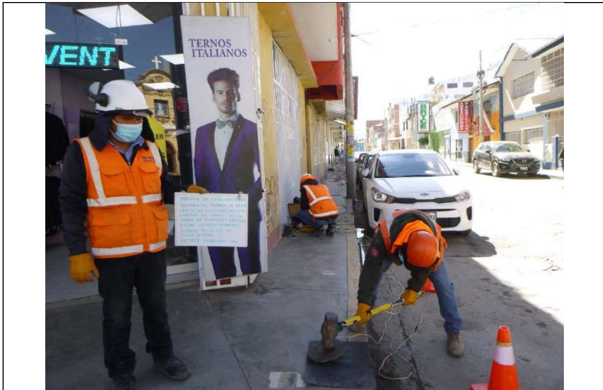
FOTO 01: Operador geofísico adquiriendo data del ensayo MASW 2D-01.
