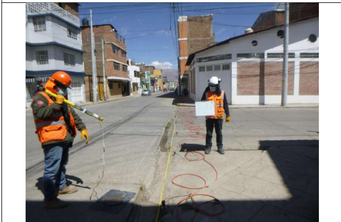
FOTO 02: Personal preparado para ejecutar el ensayo MASW 2D-01.
