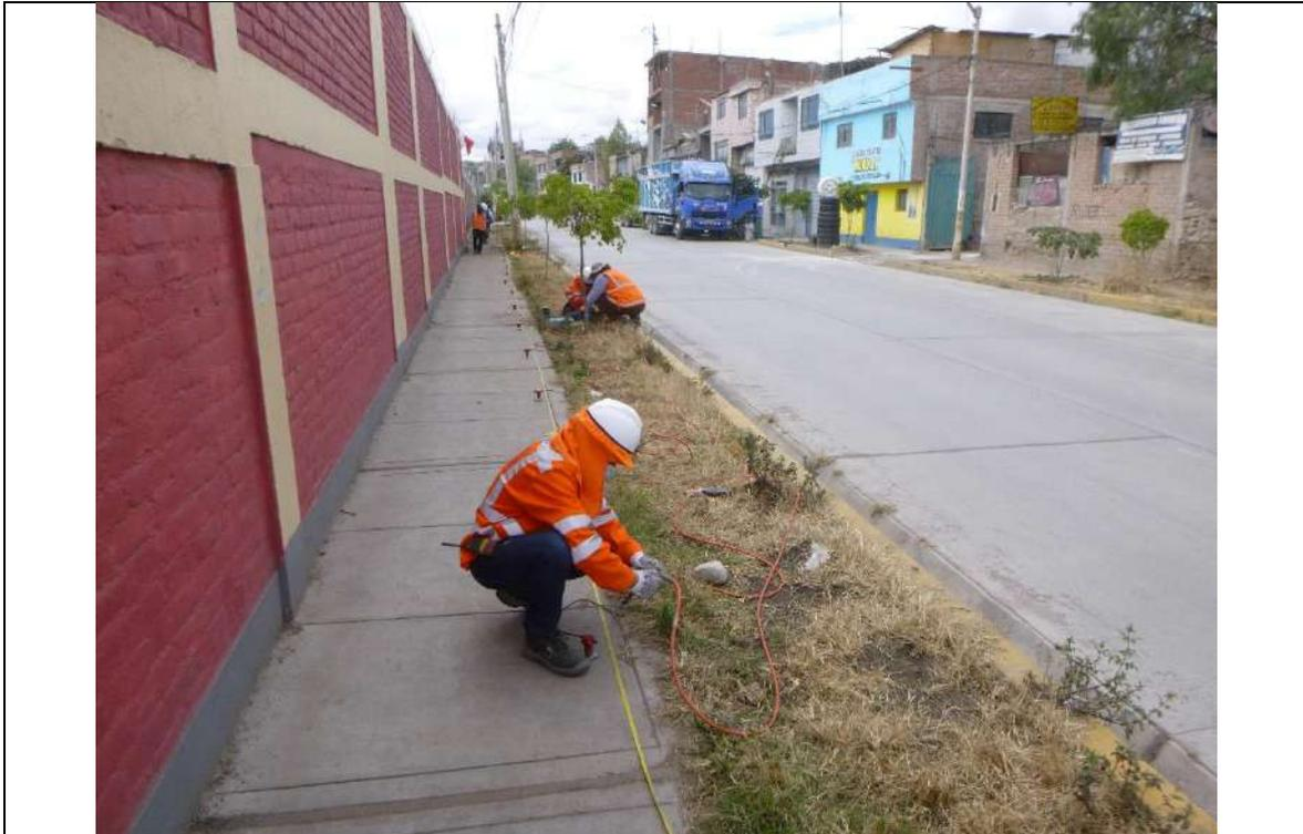
**FOTO 01:** Personal conectando los geófonos al cable sísmico para el ensayo MASW 2D -01.
