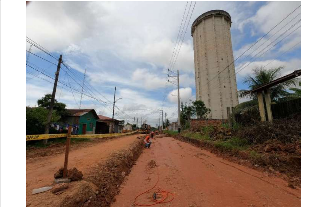
FOTO 03: Personal realizando tendido de cable y distribución de geófonos para ejecutar el ensayo MASW-02.
