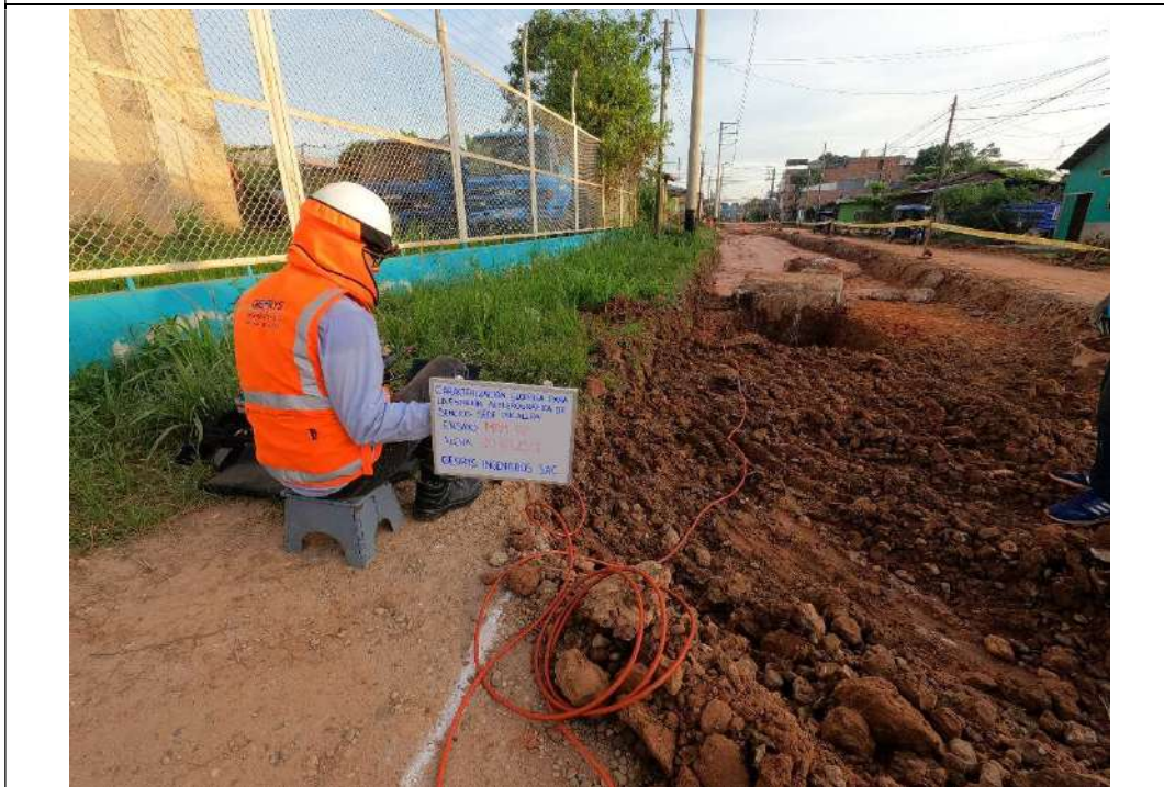
FOTO 04: Área donde se ejecutó el ensayo MAM-02.
