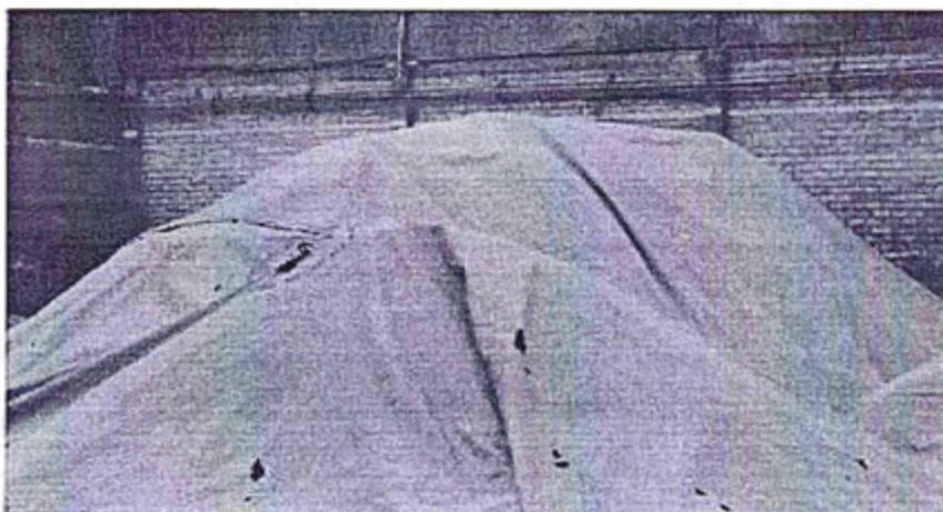
Fotografía N° 27. Manta con rajaduras, una de ellas de aproximadamente 30 cm de longitud, en el patio N° 2. Observación N° 2.
