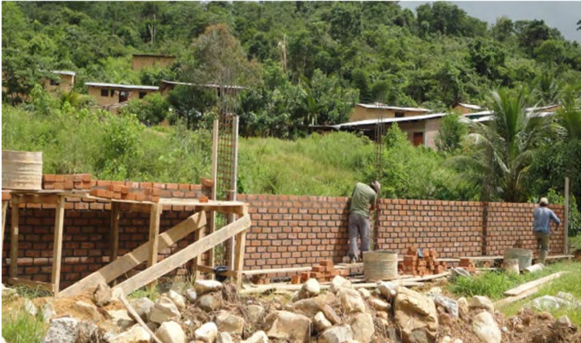
Cerco Perimétrico en proceso de construcción con Ladrillo de Arcilla Tipo Soga y Caravista
