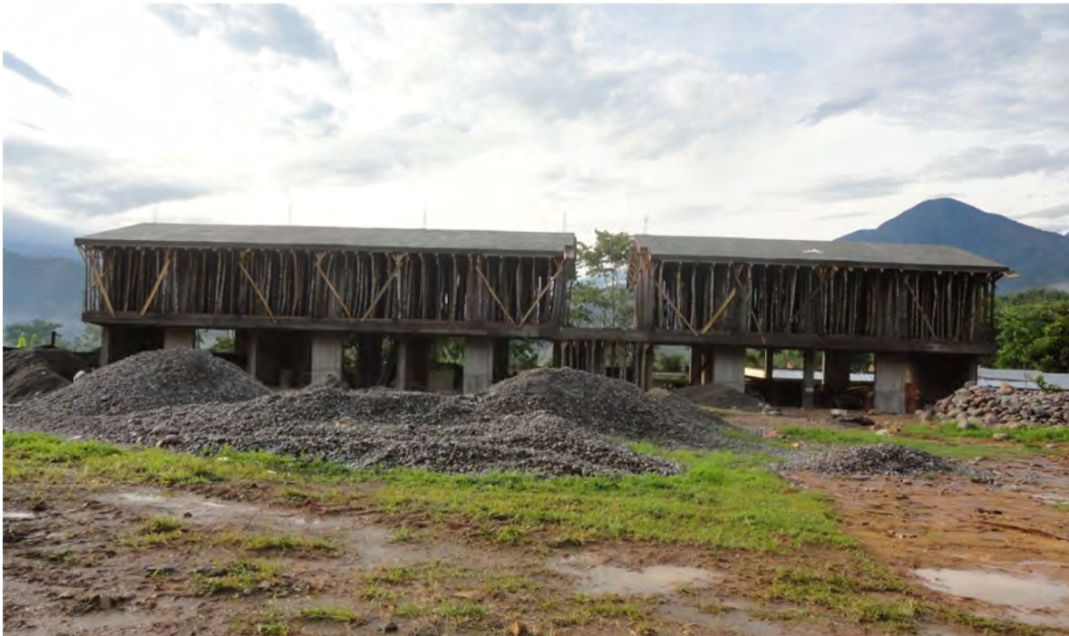
Vista Panorámica culminado a nivel de Estructura
