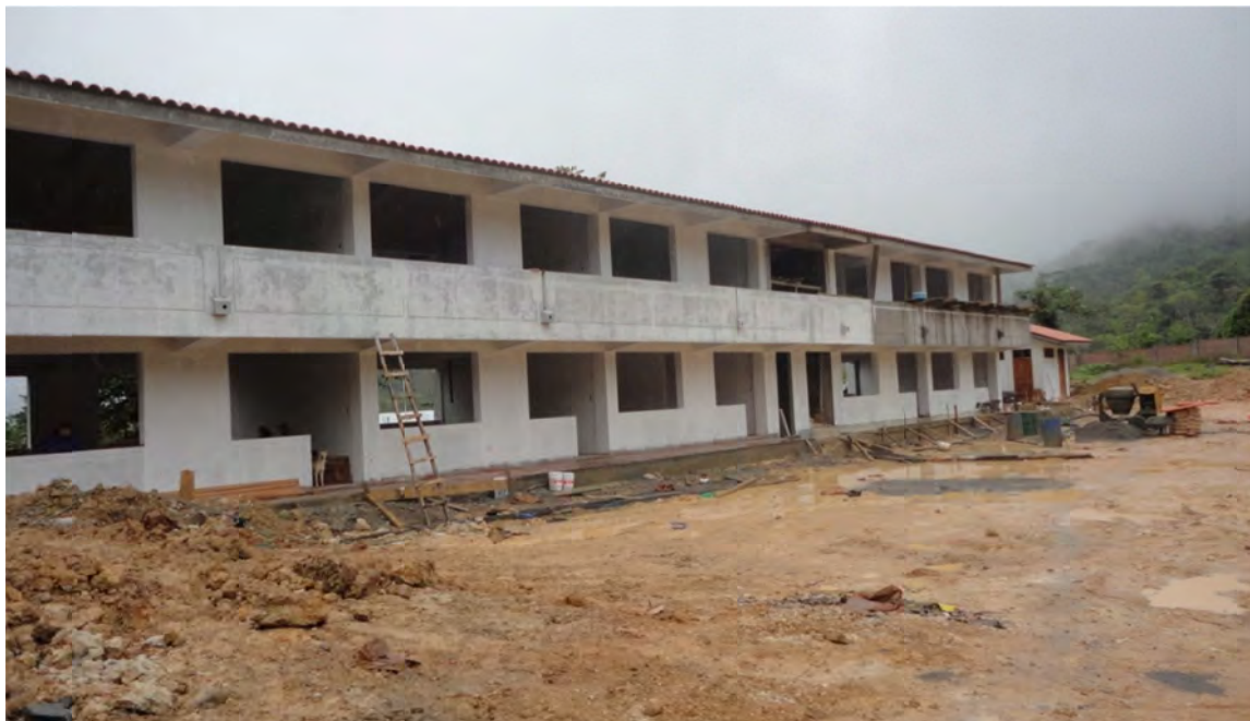
Estructura cuberturado con Teja Andina y Pintado con Material Base de los Muros Interiores y Exteriores
