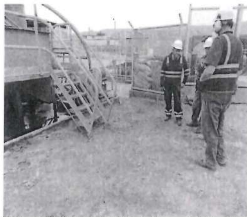
Fotografía N° 058: HALLAZGO N° 03. En la imagen se observa que la superficie exterior al sistema de bombeo, está comprendida por suelo.
