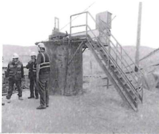
Fotografía N° 029: Hallazgo N° 01, Vista posterior del tanque de preparación de solución de cianuro de sodio.
