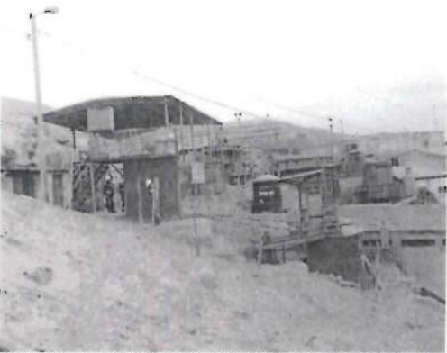
Fotografía N° 035: HALLAZGO N° 01, Vista general del tanque de preparación y almacenamiento de solución de cianuro.
