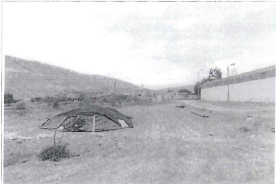
Fotografía N° 097: Hallazgo N° 4, Nótese, las huellas sobre el suelo que dejan las llantas debido al paso de equipos. También debido a los derrames de mineral el color del suelo o plataforma es plomiza.
