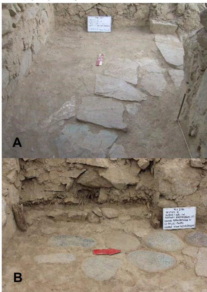
Fig. 15. Diferentes tipos de acceso a las colcas del Sector E. A) Acceso indirecto. B) Restos de postes de madera de posibles puertas.
