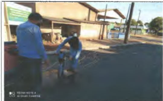
Serviço: Furo Sondagem
