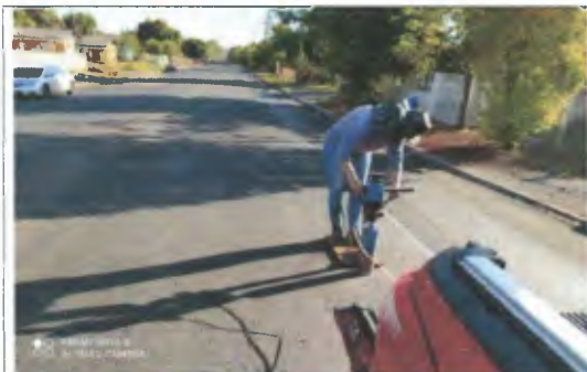
Serviço: Furo Sondagem
