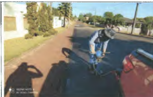
Serviço: Furo Sondagem
