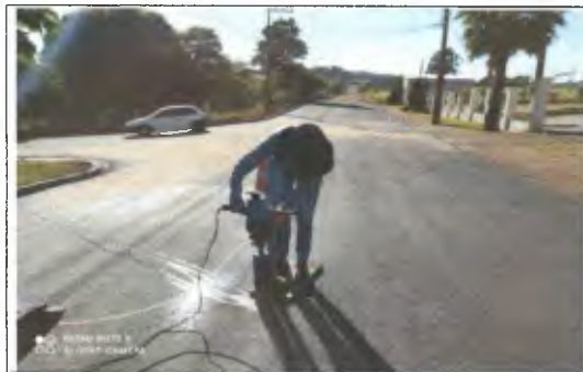
Serviço: Furo Sondagem
