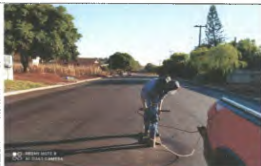
Serviço: Furo Sondagem
