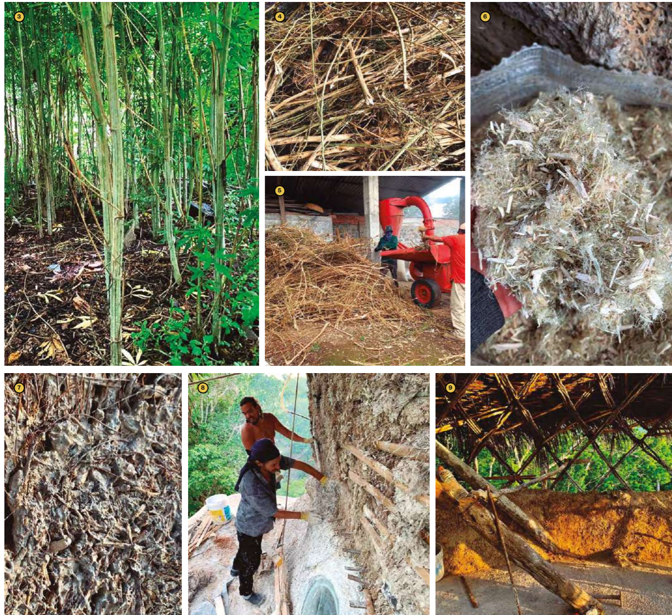
1 Bioconstrucción en Xpuha, Quintana Roo. 2 Tallo de cáñamo cultivado en Michoacán. 3 Cultivo de cáñamo. 4 Cáñamo seco. 5 Triturado del cáñamo. 6 Picadura de cáñamo. 7 Detalle del muro. 8 Aplanado del muro en la bioconstrucción. 9 Detalle del muro hecho de picadura de cáñamo.
