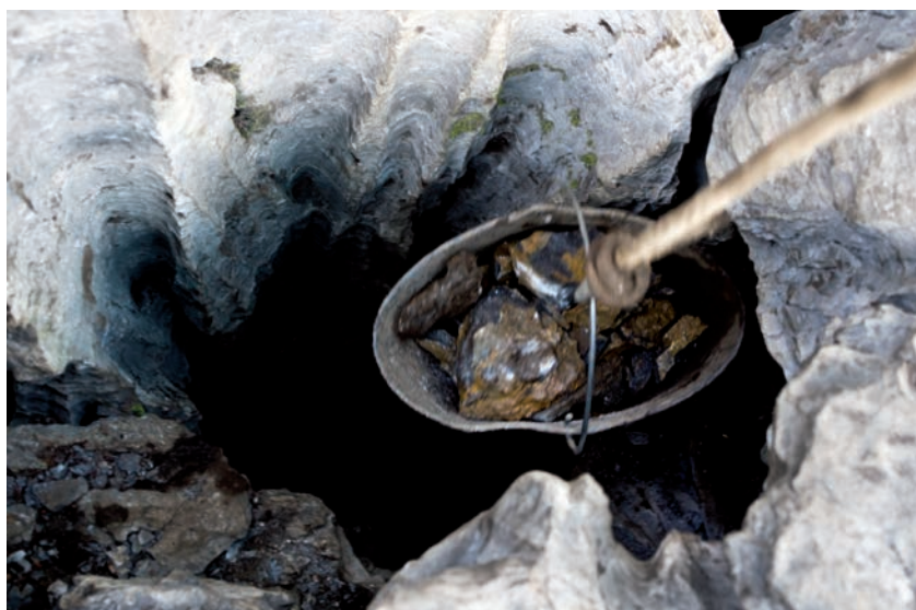
Labores de desescombro.
