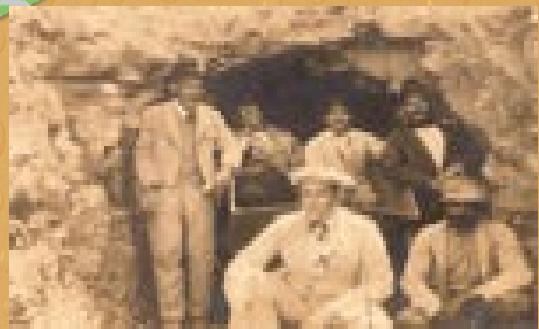
Trabajadores en las galerías de Famara
