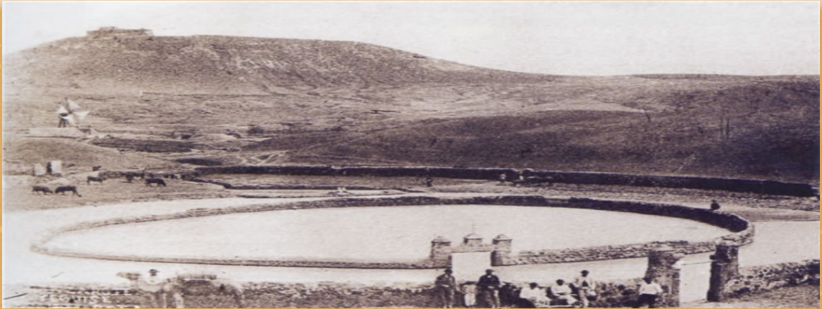
La Mareta de la Villa de Teguisse con su doble muro de piedra (1890).
