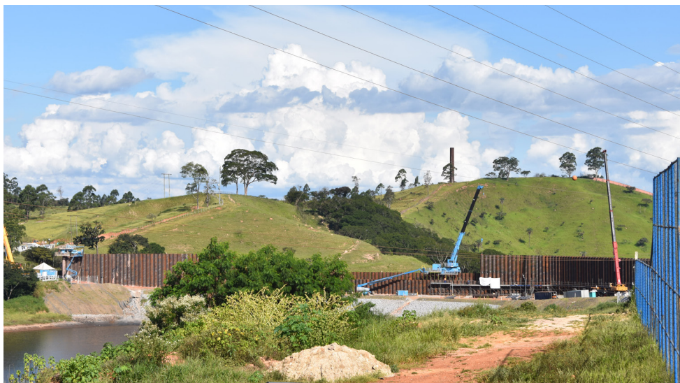
Obras de construção do muro na região do Coqueirinho, próximo ao bairro Nova Vista. Fonte: Comitê Popular dos Atingidos pela Mineração de Itabira e Região.
